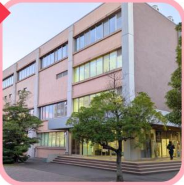
全学講義棟1号館
