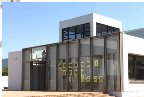
D館 建物全景
