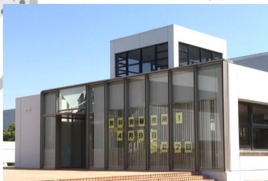
D館 建物全景
