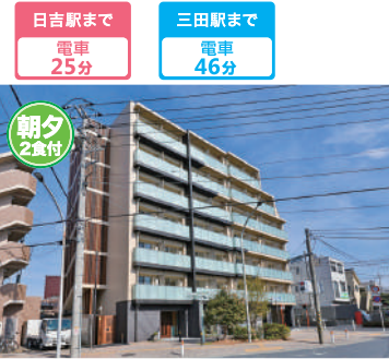
R6年1月完成・鉄筋7階・全114室・総合補償要・神奈川県川崎市多摩区宿河原1
